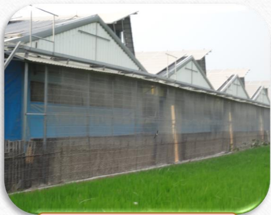
禽舍架設防鳥設施
